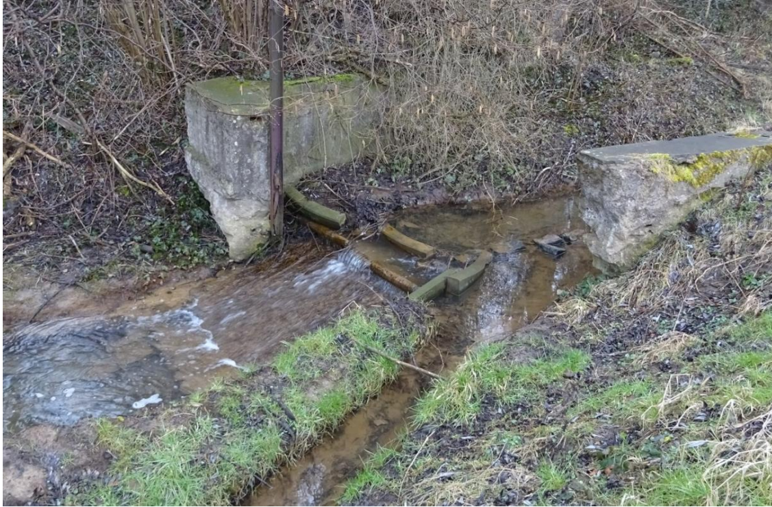
Abb. 4: Stauanlage bei Fl.-km 0+980. Quelle: BCE Begehung 28.03.2018
