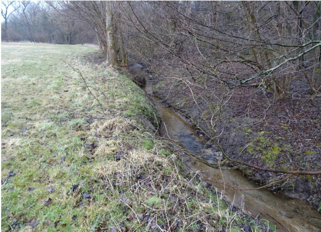
Abb. 5: Aufnahme Gewässerbegehung Johannisteichgraben, Station km 1+050, Blick nach Unterstrom, Aufnahmedatum: 28.03.2018
