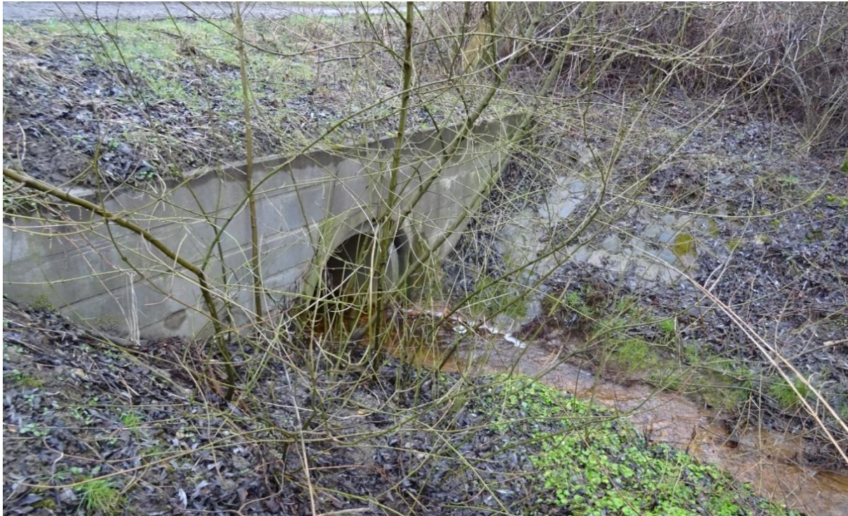
Abb. 7: Verrohrung bei Fl.-km 1+480. Quelle: BCE Begehung 28.03.2018
