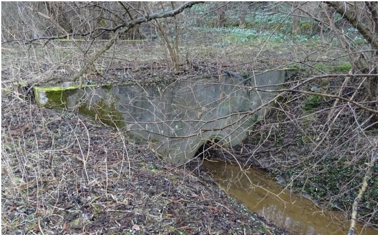
Abb. 6: Verrohrung bei Fl.-km 1+220. Quelle: BCE Begehung 28.03.2018
