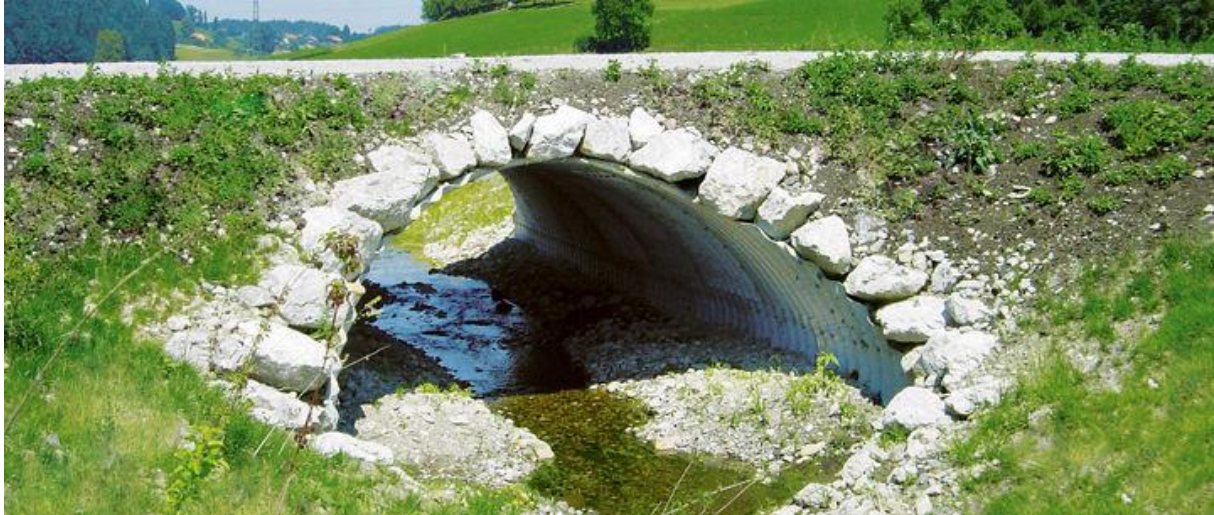
Abb. 12: Ausführungsbeispiel Maulprofilrohr. Quelle: www.sytec.ch
