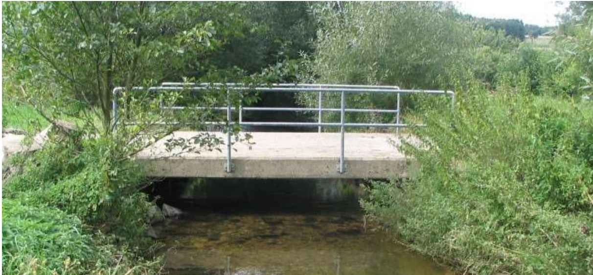
Abb. 13: Ausführungsbeispiel Plattenbrücke. Quelle: Th. Meurer
